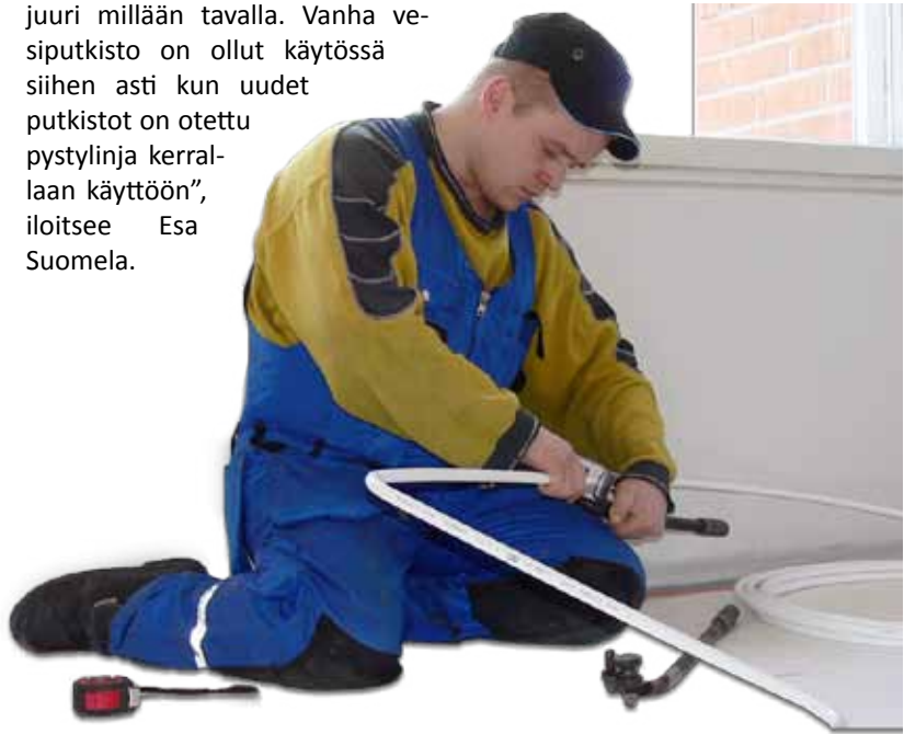
Vuotovesisuojaattua Cupori 141 (Fincu) -kupariputkea on asentajan helppo työstää ja taivuttaa.
